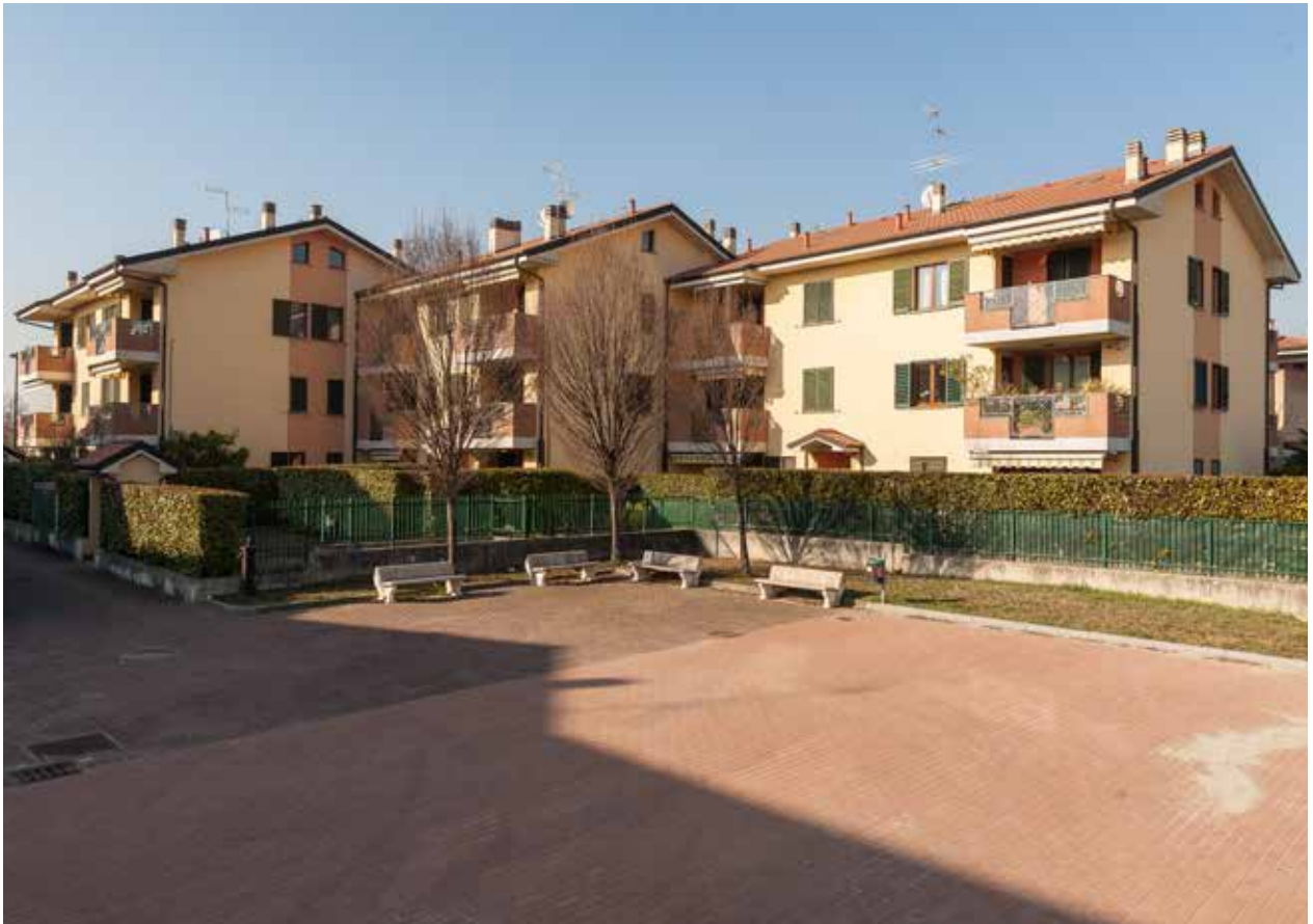
Condominio La Fornace, via Guido Rossa 7
